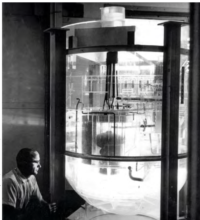
Modèle réduit (échelle 1/6) du "Molten Salt Reactor Experiment" (MSRE) d'Oakridge (USA). Le MSRE a divergé le 1 er juin 1965, et a atteint sa pleine puissance (7500 kW) en mai 1966.
