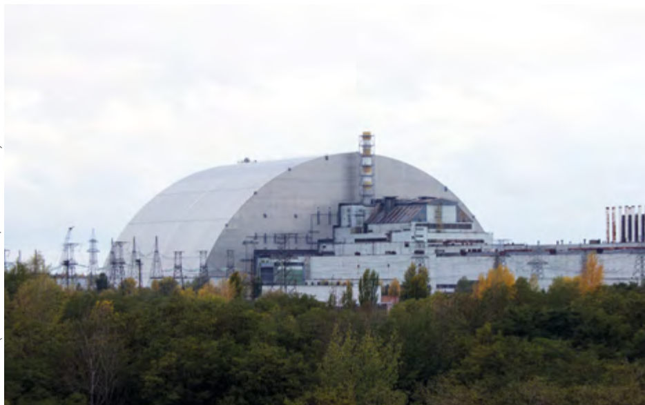
1. L'enceinte de confinement du réacteur n°4 accidenté de la centrale nucléaire de Tchernobyl en Ukraine et de son premier sarcophage, mise en service en 2019. Haute de 108 m, large de 162 m pour une portée de 257 m, elle est conçue pour une durée de service de 100 ans.
